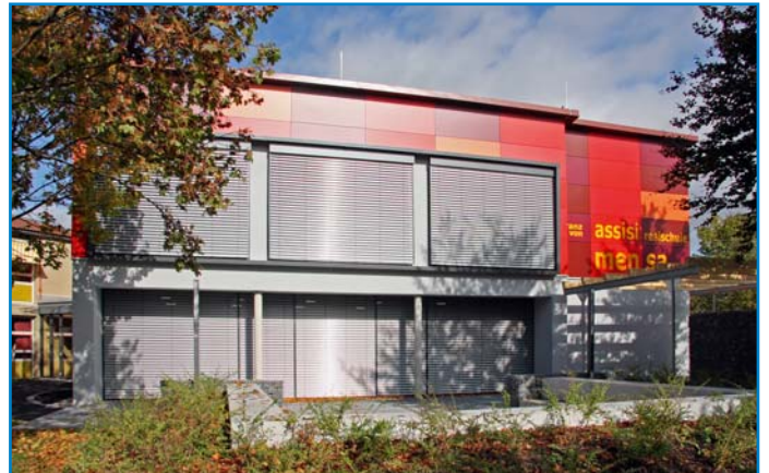
Im neu errichteten Erweiterungsbau befinden sich Mensa, Musikaal, Spielraum, Projektraum, Bibliothek und Elternsprechzimmer. Träger der Franz-von-Assisi-Realschule ist die Stiftung Katholische Freie Schule. Die Gesamtkosten für die Schulerweiterung beliefen sich auf ca. 2,57 Mio. €, auf die Gemeinde Waldstetten entfiel ein Anteil von rd. 835.000 €.
