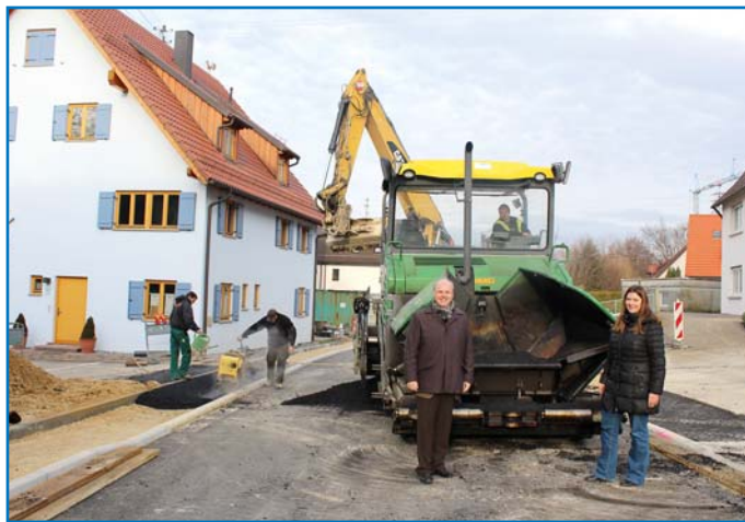
Bürgermeister Michael Rembold und Ortsbaumeisterin Maren Zengerle freuen sich, dass die Sanierung der Hauptstraße im Zeitrahmen ist. Anfang Dezember wurden Straße und Bürgersteig asphaltiert, sodass die Hauptstraße über die Wintermonate für den Verkehr freigegeben werden konnte.
