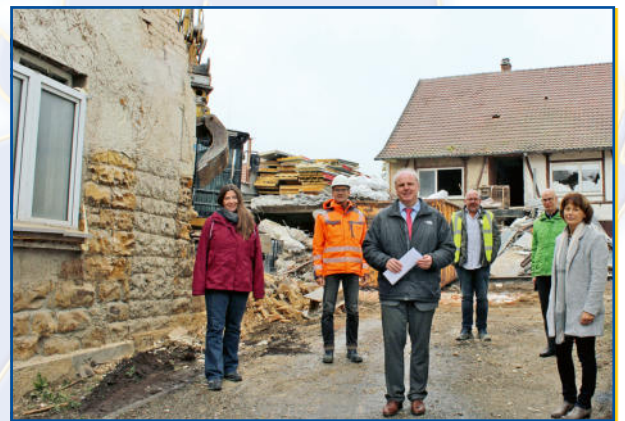
Die Abrissarbeiten sind im vollen Gange, weshalb Schultes Michael Rembold zum Pressegespräch einlud (v.l.): Ortsbaumeisterin Maren Zengerle, Uli Calmbach vom Ingenieurbüro VTG Straub aus Donzdorf, Schultes Michael Rembold, Markus Christadler, Geschäftsführer der Firma CK Abbruch & Erdbau GmbH aus Eislingen sowie Kämmerer Gerhard Seiler und Ortsvorsteherin Monika Schneider.
