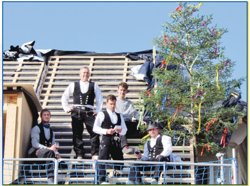
Jakob Appenzeller von Holzbau Moser trägt den Richtspruch vor.
