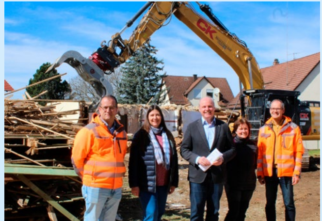
Vor dem Hintergrund des Abrisses des Gebäudes von Georg Grupp freuen sich (v.l.) Nedzad Halilagic, Bauleiter der Firma CK Abbruch, Ortsbaumeisterin Maren Zengerle, Schultes Michael Rembold, Quartiermanagerin Magdalene Rupp sowie Uli Calmbach von VTG Straub über den nächsten Schritt zur Realisierung des Wohnprojektes Löwen-Areal in der Wißgoldinger Ortsmitte.
