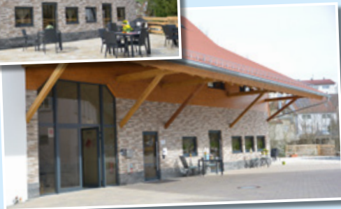
Eingangsbereich und Terrasse. Der sich über das gesamte Geschoss erstreckende Raum unterm Dach mit herrlicher Akustik kann für Veranstaltungen angemietet werden
